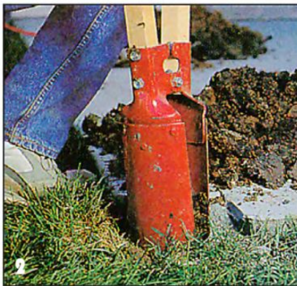
Для выкапывания скважин под опорные сваи пользуются садовым буром или специальной лопатой. На дно скважин отсыпают слой щебня.
