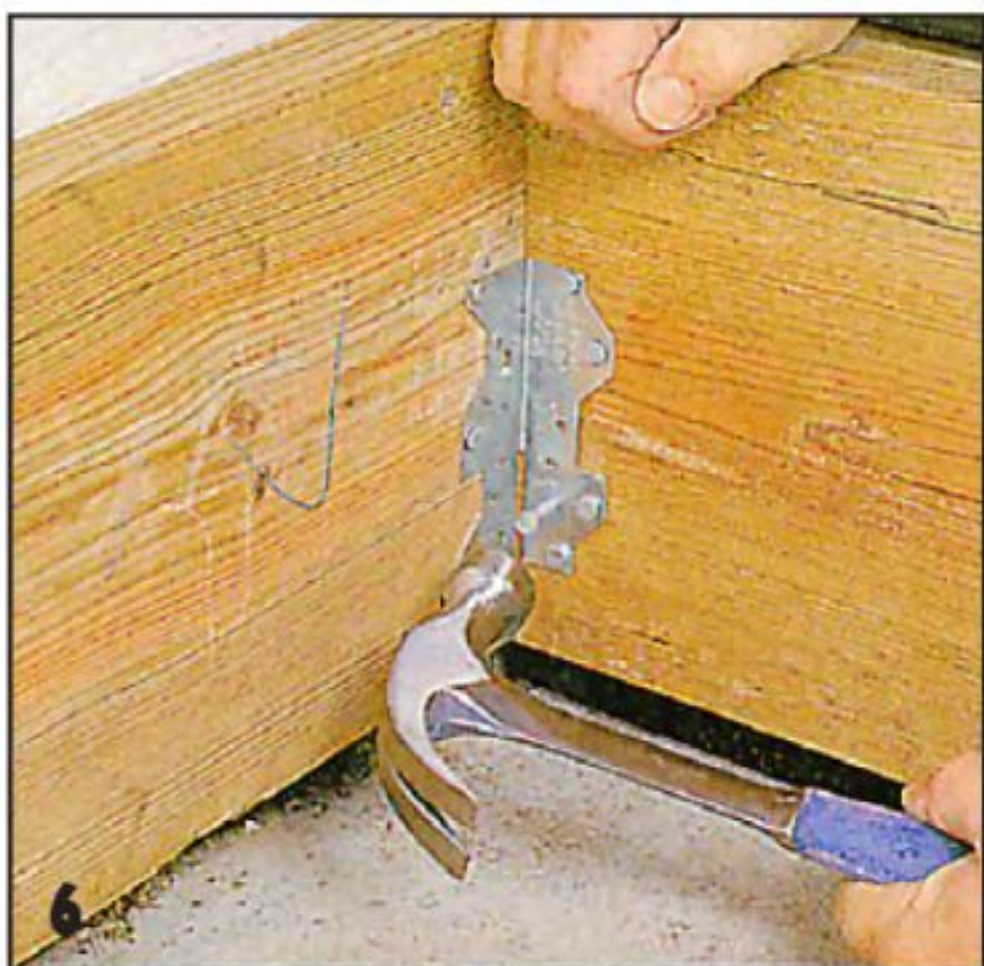
6 Доски каркаса соединяют на монтажных уголках, которые прибивают к доскам заёршёнными оцинкованными гвоздями.
