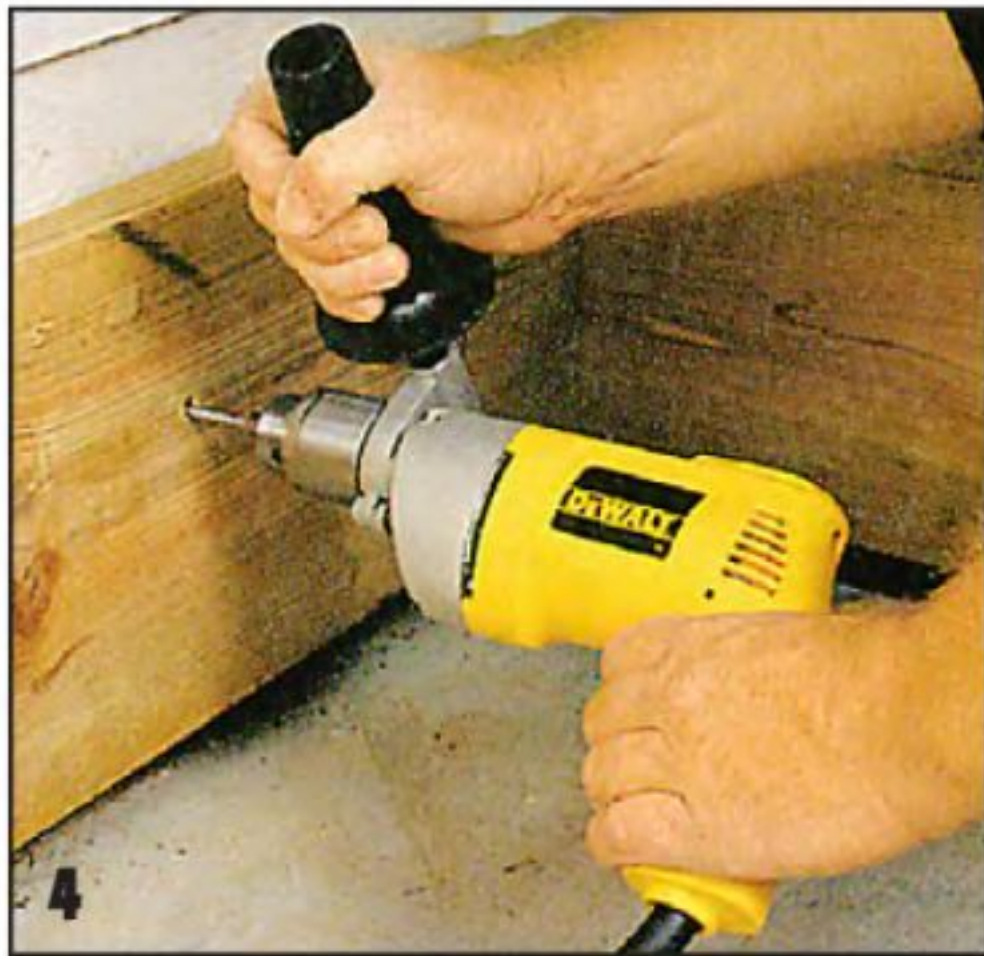
4 Заднюю доску наружного каркаса прихватывают к стене дома парой шурупов, а затем, просверлив четыре отверстия соответствующего диаметра, крепят доску анкерными болтами.
