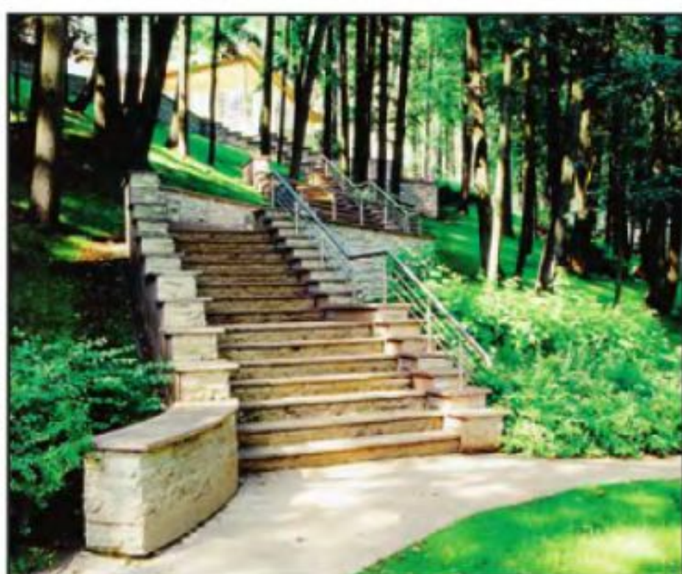
Малоступенчатая цельная межтеррасная лестница.
