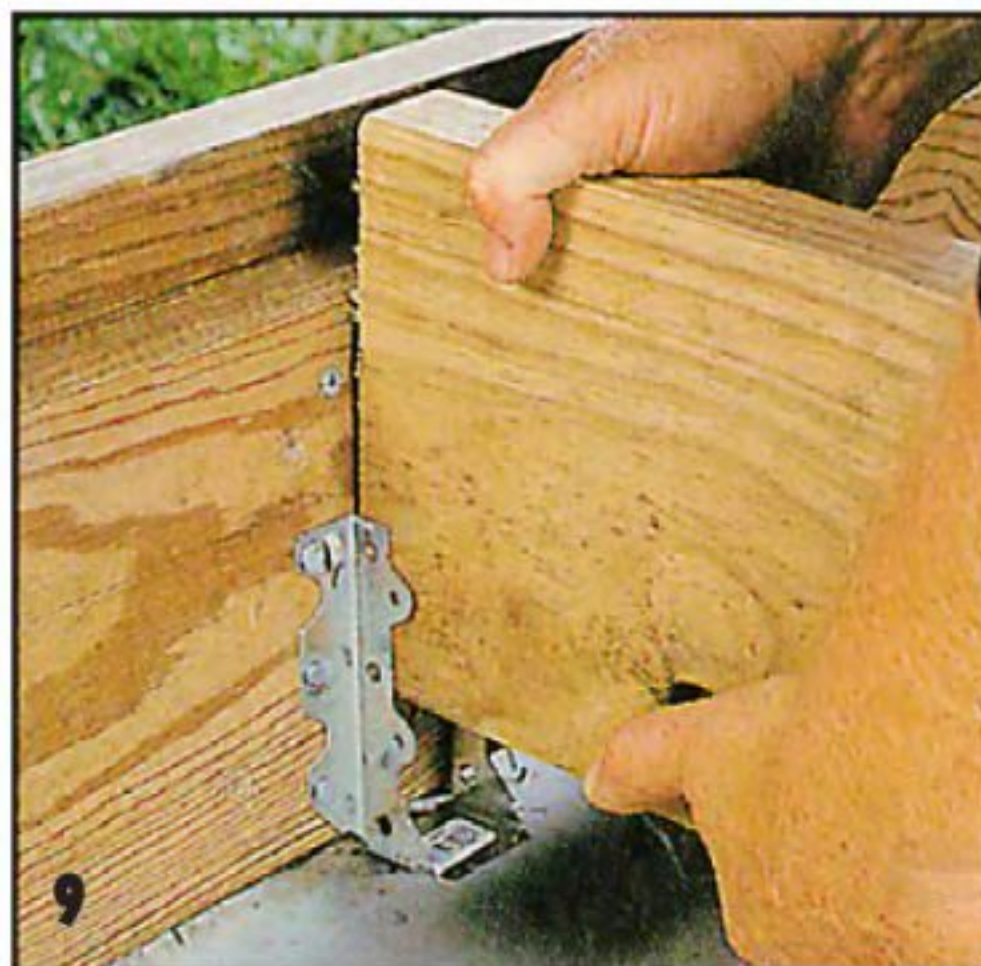
9 На передней и задней досках внутреннего каркаса по разметке крепят монтажные кронштейны под поперечные лаги.
