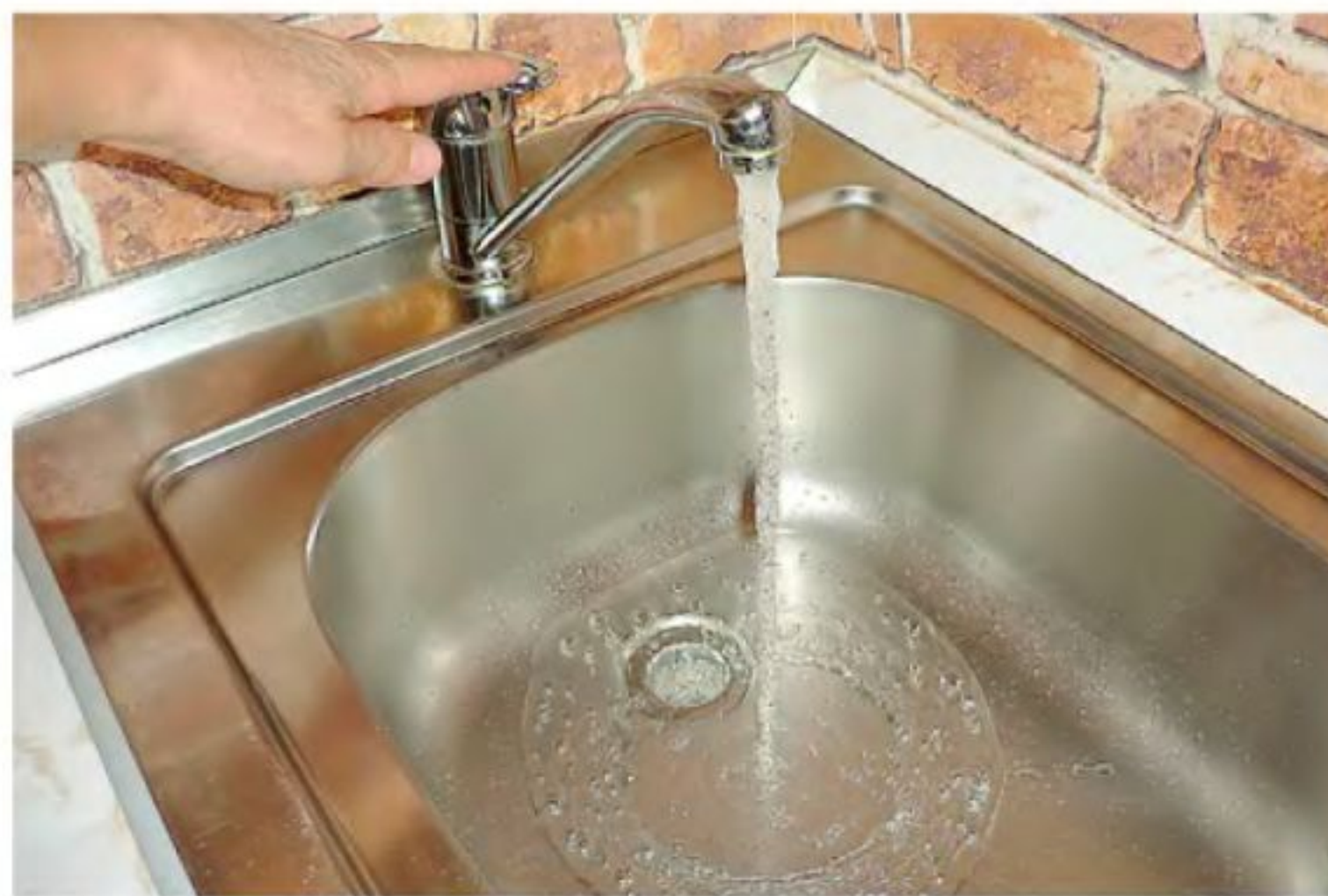
Финишная операция, которую выполняют после установки нового сифона. Открыв кран с водой, проверяем все соединения сифона на течь.
