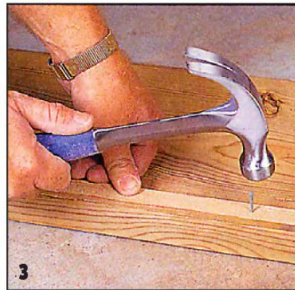
Если между домом и бетонной плитой есть зазор, его заделывают обрезком доски соответствующего размера.
