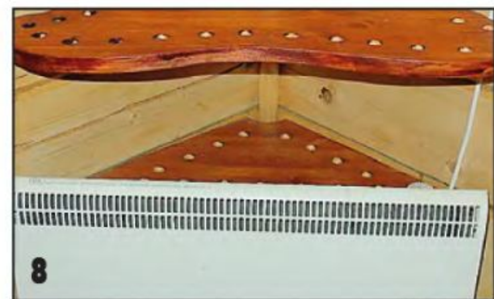
Установленный в шкаф электрический конвектор сушит одежду и обувь. Чтобы на пути нагретого воздуха было меньше препятствий, в полках просверлили отверстия.
