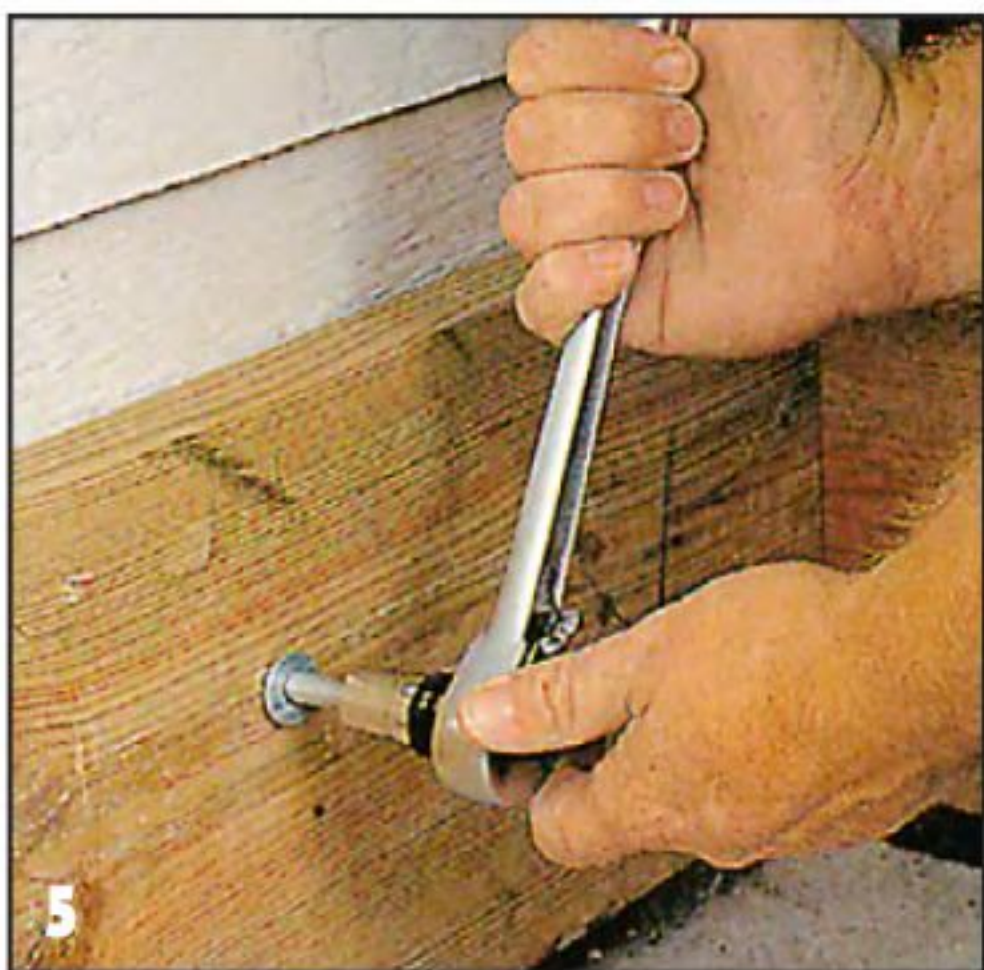
5 Болты с распорными дюбелями вставляют в отверстия и затягивают ключом.
