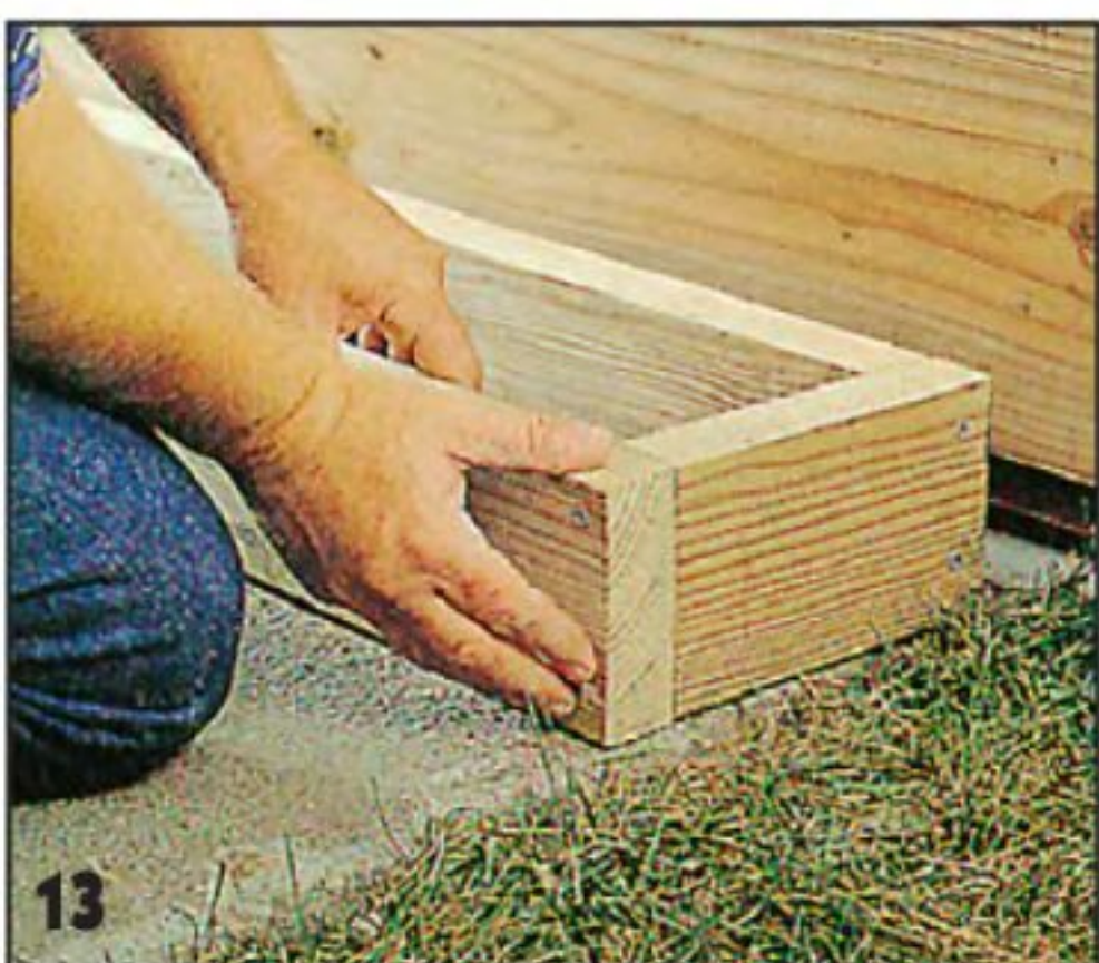
Каркас ступеньки собирают из досок и ставят на бетонную подушку.
