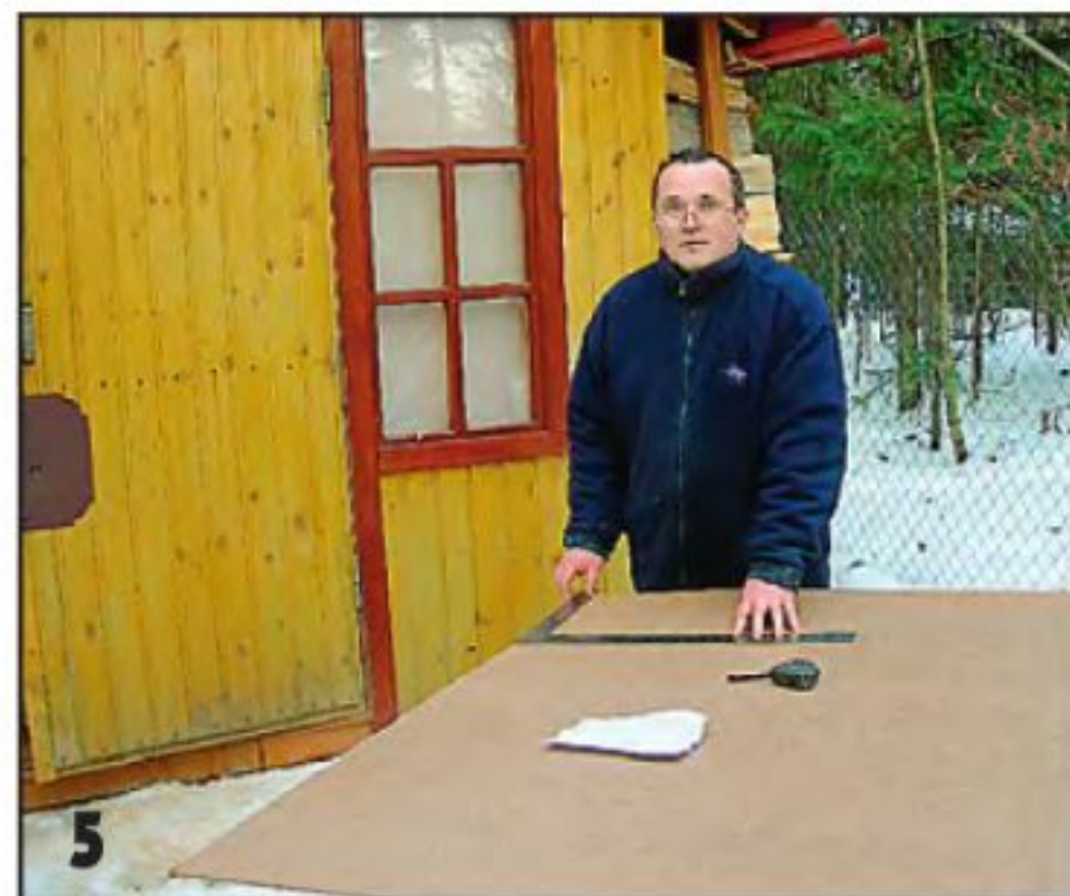
По расчётным размерам выкраиваем филёнки из ДВП.
