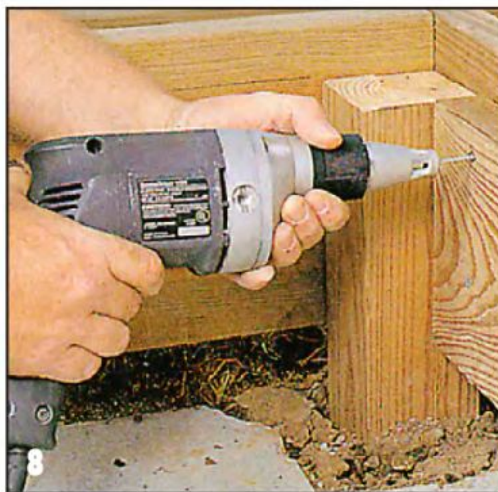
8 Изнутри наружный каркас усиливают краевыми лагами (внутренним каркасом).
