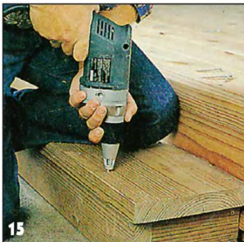
Сверху каркас ступени накрывают доской, которую приворачивают к нему шурупами.
