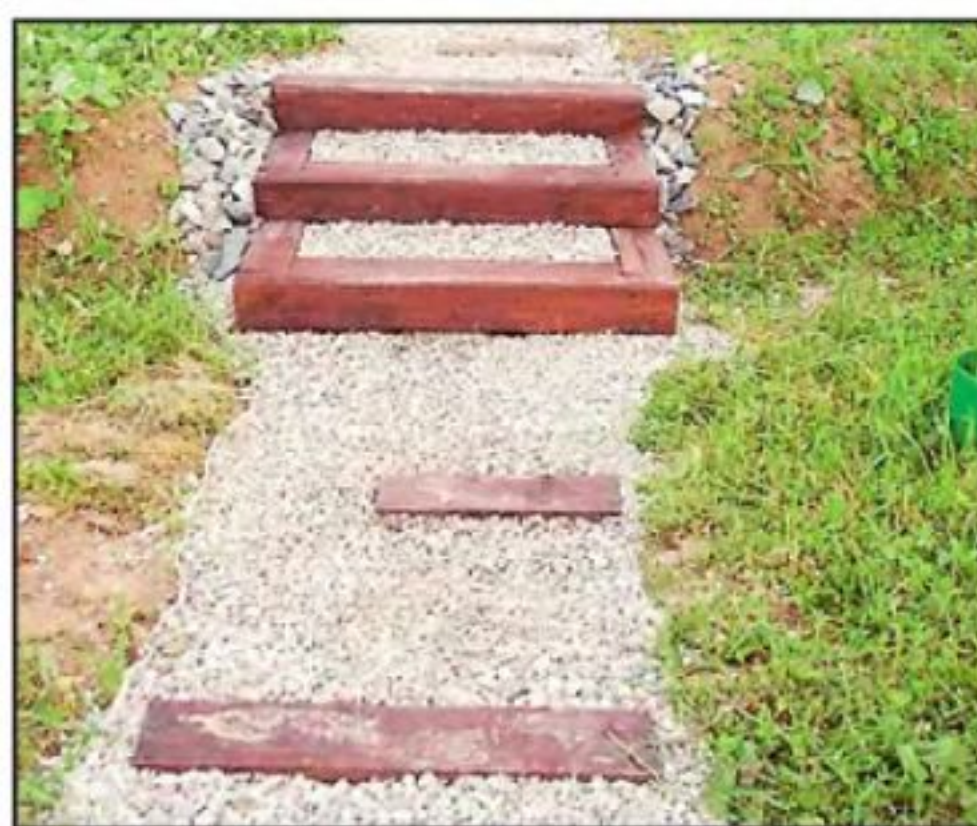
Засыпная межтеррасная лестница.
